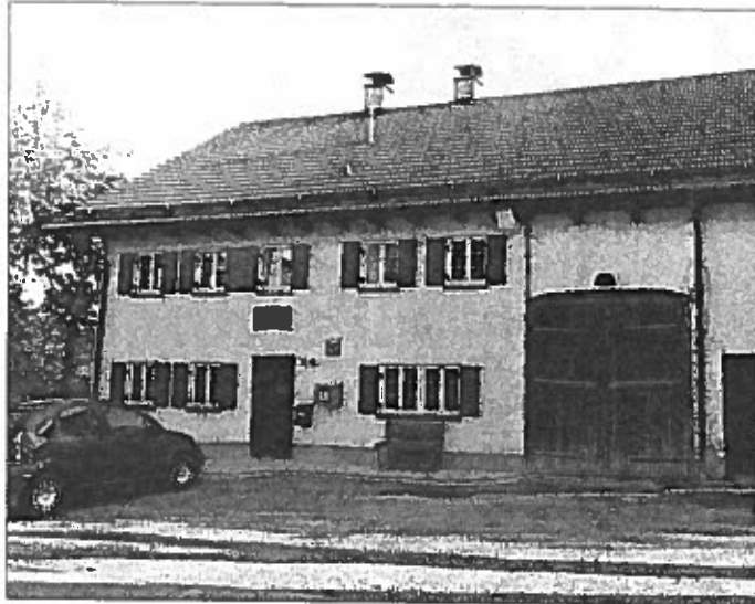
Beim alten Bauernhaus der ehemaligen Sattlerin Wilhelm gegenüber dem Sonnenhof wird im Bereich der Tenne saniert. Foto: Kübler
